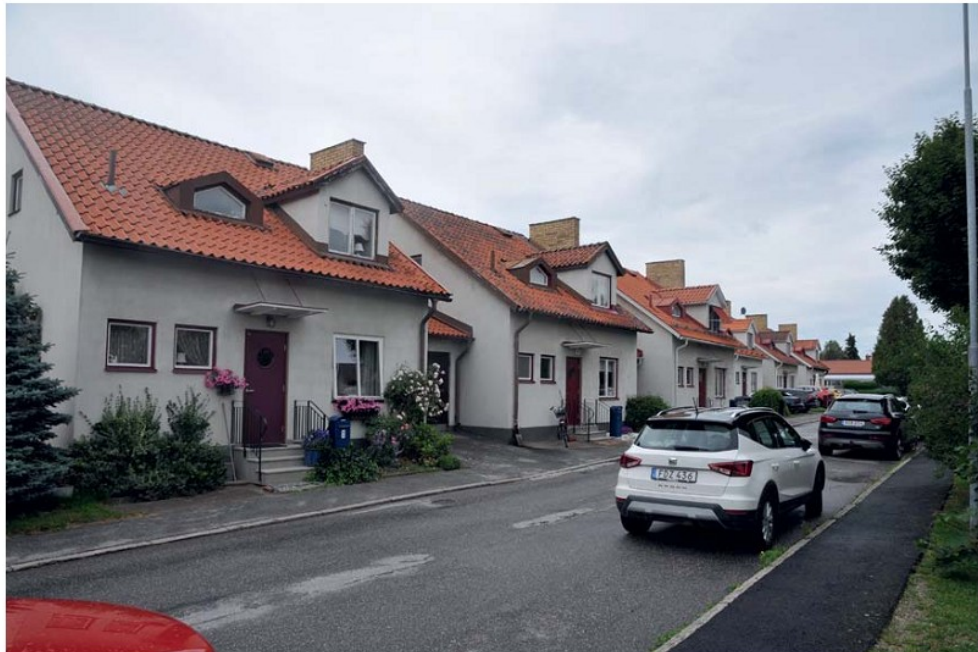
Tre värmecentraler fördelade bland de 37 rad- och kedjehusen i Västerås, kortade ned kulvertsträckorna.
